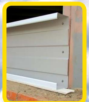
**4.** В канавки верхней полки сэндвич-профиля наклейте два горизонтальных уплотнителя УПСГ.
