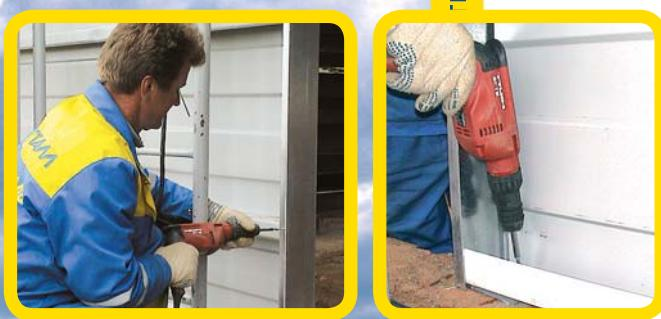
**5.** Следующий сэндвич-профиль МП СП ставится на верхнюю полку нижнего профиля и скрепляется саморезами Ø 4.2 x 16 (19) с ней (с шагом около 500 мм) и саморезами Ø 5.5 x 32 с колонной каркаса. Целесообразно вести монтаж сэндвич-профилей на всю высоту стены, чтобы после укладки теплоизоляции его можно было бы сразу закрыть ветрозащитой и облицовкой.
