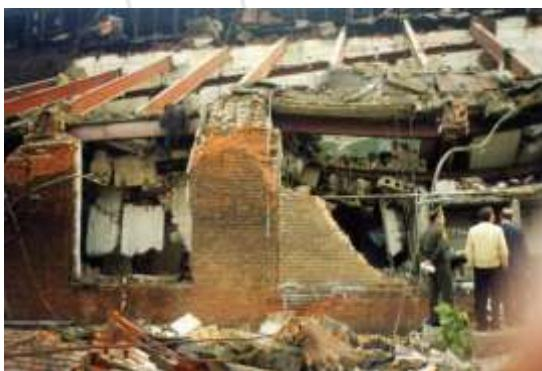
Рисунок 1.1.16 - Последствия аварийного взрыва на заводе «Серп и молот»
