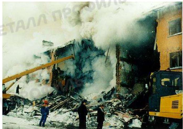
Рисунок 1.1.15 - Обрушение жилого кирпичного дома в результате аварийного взрыва
